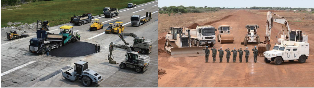
〈그림 7〉 한빛부대 활주로 보수(左) / 韓 공군 공병부대 활주로 피해복구(右)
