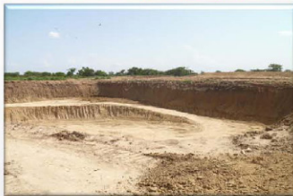
쓰레기 처리장 설치
