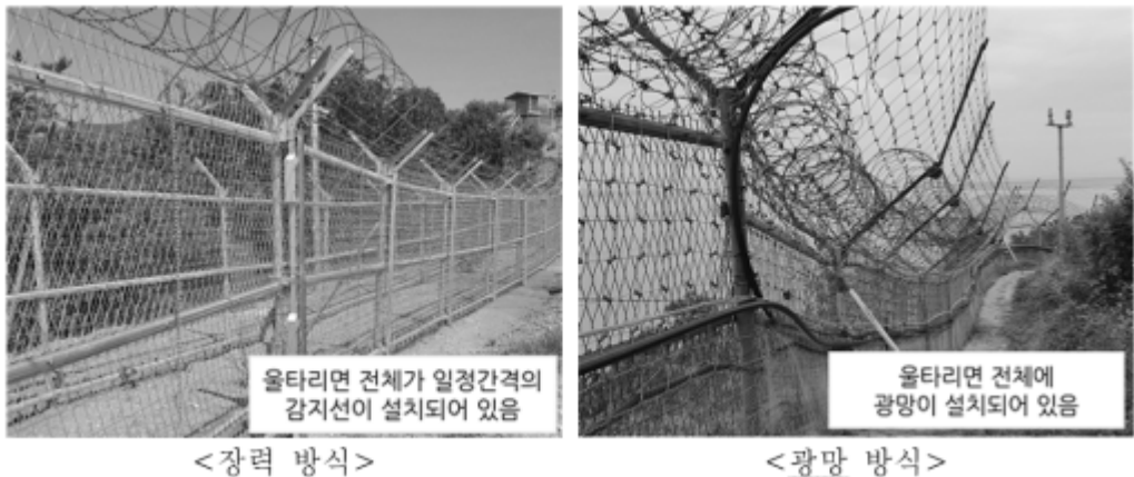
[그림 24] 면 감지 방식의 침입감지시스템 설치 모습
